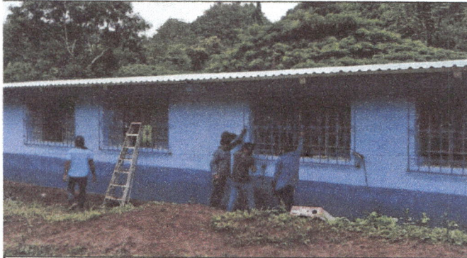
Mantenimiento a balcones de metal.
