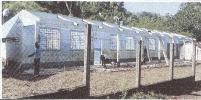
Instalación de la estructura de techo de metal y cubierta de lámina troquelada del módulo de aulas.
