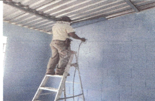
Aplicación de pintura en muros interiores y exteriores.
