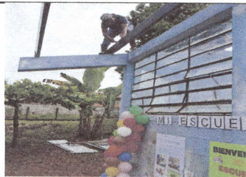
Mantenimiento de la estructura de techo del segundo módulo de aulas.
