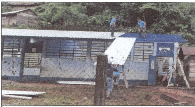
Instalación de la cubierta de lámina troquelada del segundo módulo de aulas.
